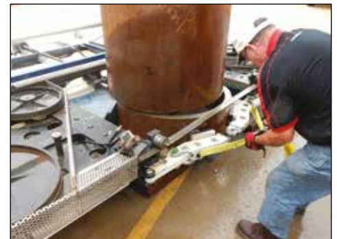
▲ Rohrtrennung mit BS-Bandsäge von Mirage.
