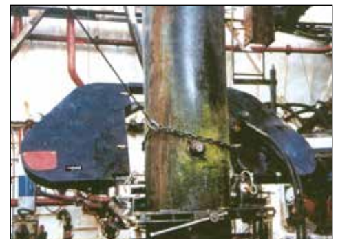
▼ Abbrucharbeiten mit Bandsäge.
