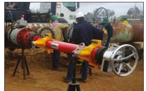
▲ CHT3000 Hot-Tapping-Anwendung für Installation von petrochemischen Rohrleitungen.
