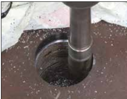
▲ Vergrößern einer Bohrung
